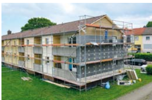
Modernisierung der von uns erworbenen Häuser
