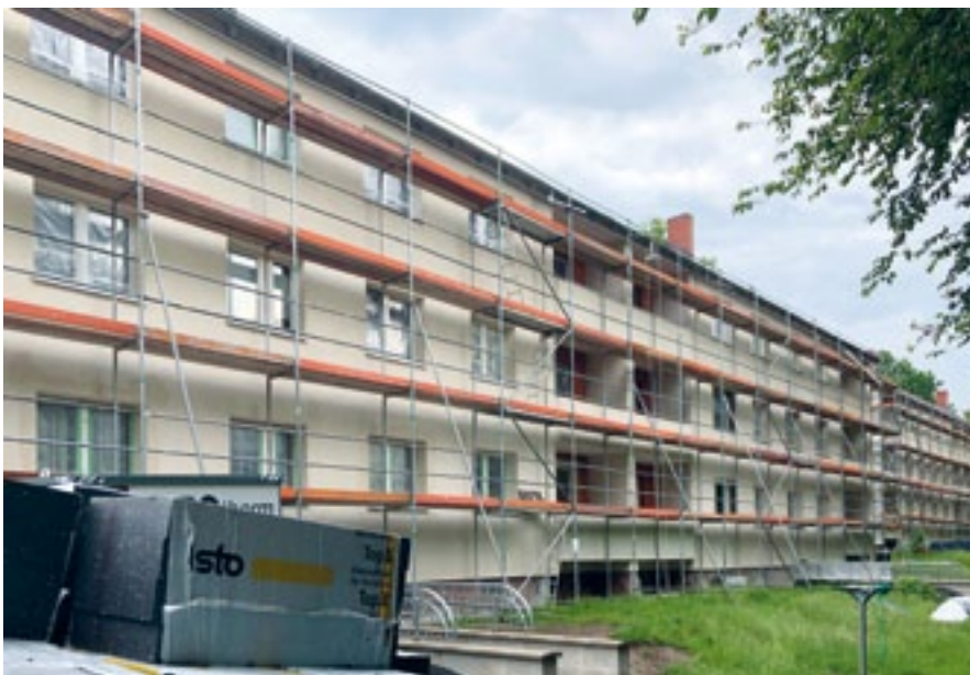
In der Talstraße in Seesen sind die Modernisierungsarbeiten in vollem Gange.
