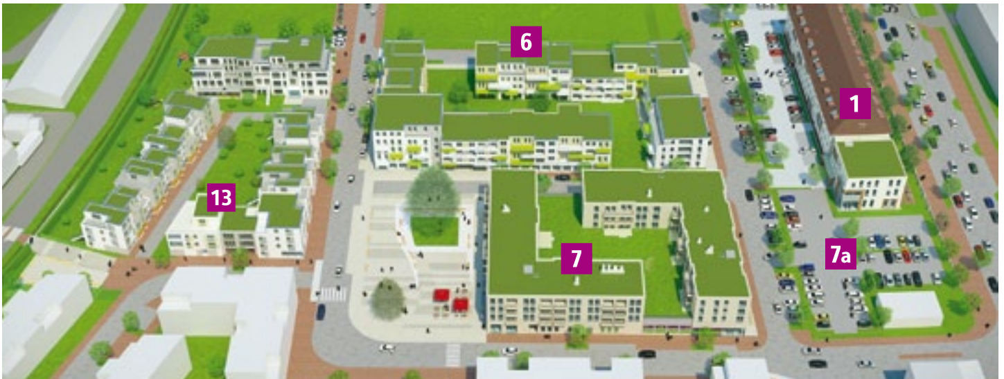
Ansicht des gesamten BWV-Projektes mit den verschiedenen Baufeldern.
